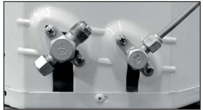
FIG. 39 - CONEXÃO DA LINHA DE EXPANSÃO DA UNIDADE CONDENSADORA
